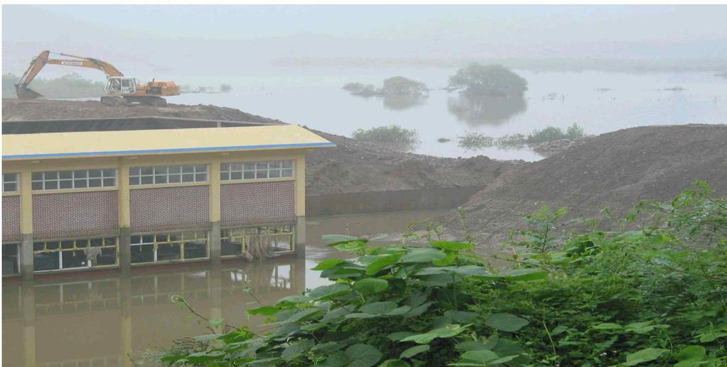
[해설 사진 8.2.3] 수문 접합부 누수로 인한 제방 붕괴 예
